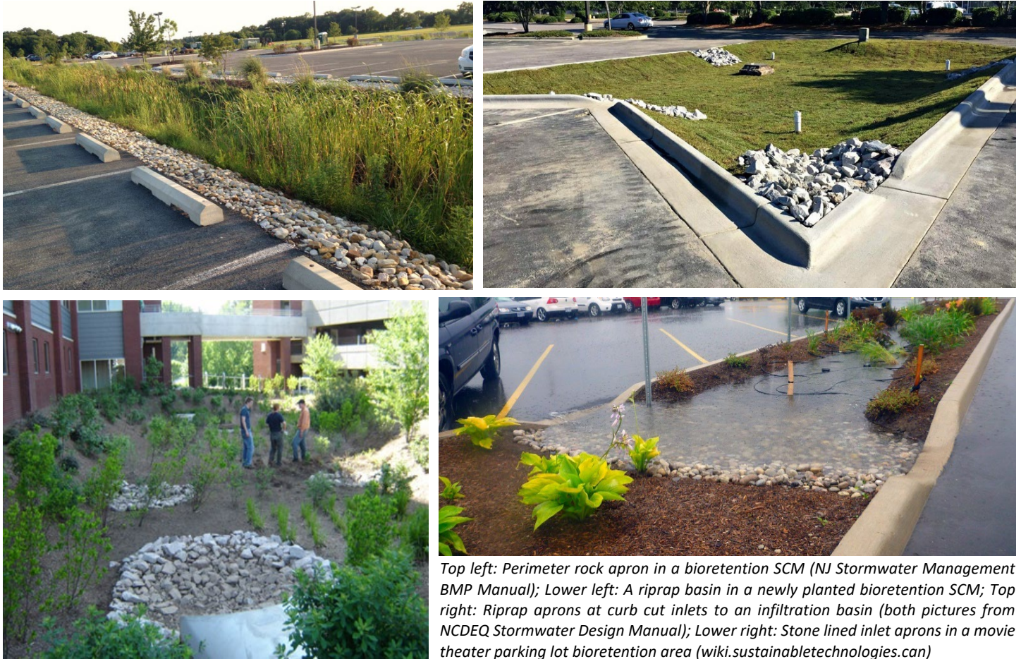
Figure 5.16.4.1 Example Riprap Aprons
